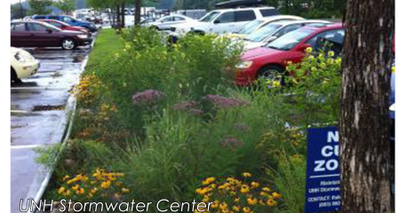
Bioretention Retrofit, UNH Campus, Durham, NH
